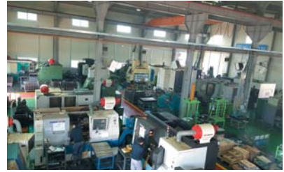
▲가공 Line 전경
